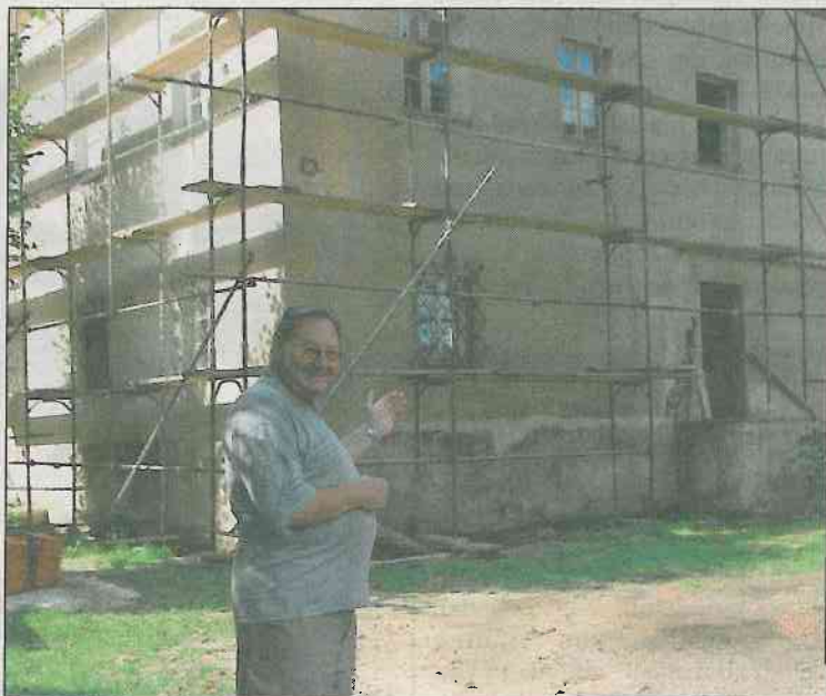
Der Ladendorfer Pfarrhof wird generalsaniert. Pfarrer Dechant Walter Pischtiak „lebt“ derzeit im Pfarrstadel und hofft bald wieder in den historischen Pfarrhof einziehen zu können.
